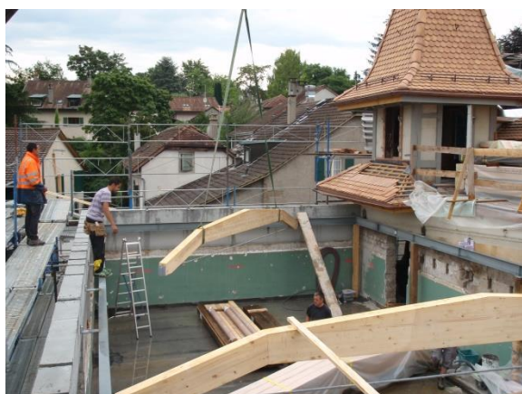
Illustration : pose de la charpente bois
