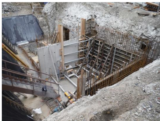
Illustration : réalisation des fondations contre les voûtes
