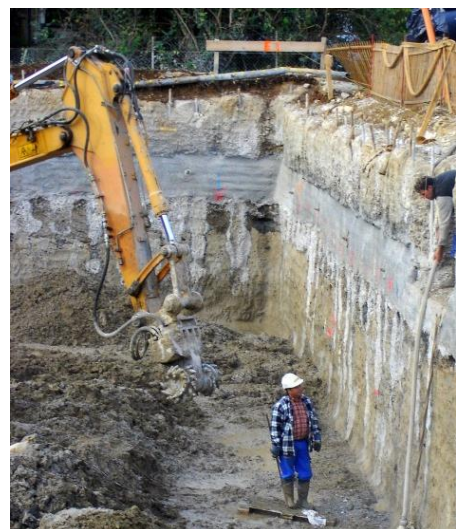
Illustration : forage des colonnes Jetting
