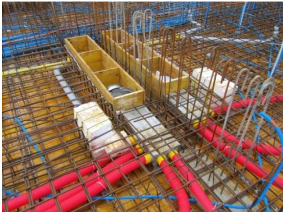
Illustration : armatures de dalle, trémies
