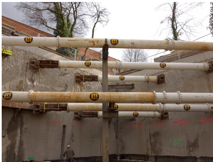
Illustration : Étayage de la paroi moulée
