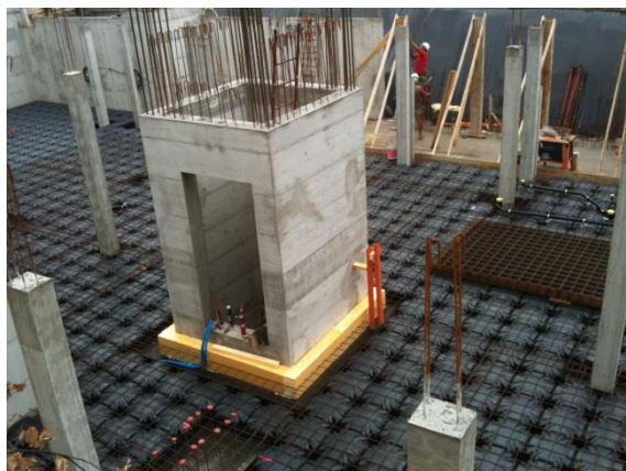
Illustration : Ferraillage radier
