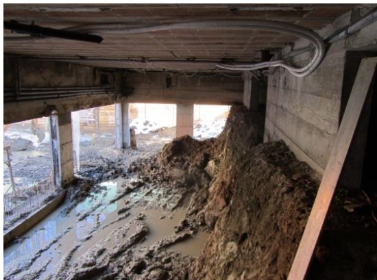
Illustration : reprises en sous œuvre, excavation en taupe
