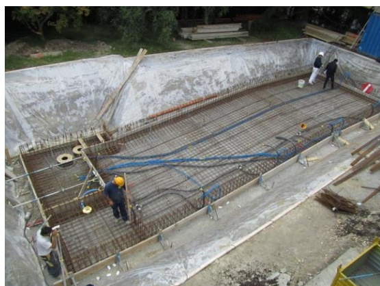
Illustration : bétonnage du radier de la piscine
