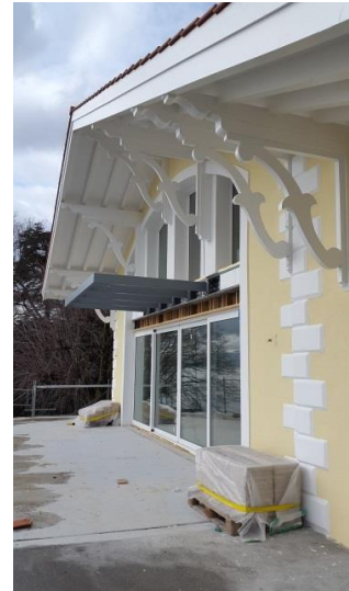
Illustrations : baies vitrées créées
