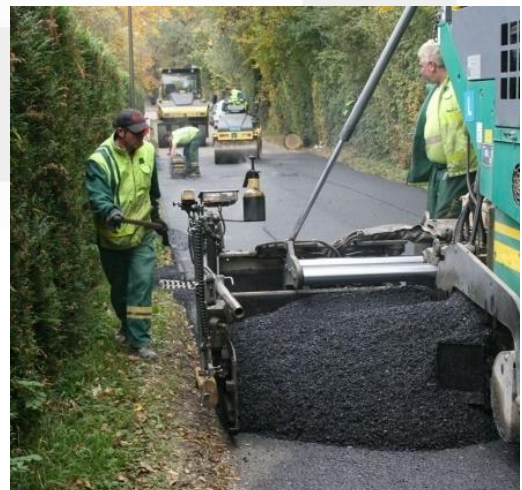
Illustration : réfection de la chaussée
