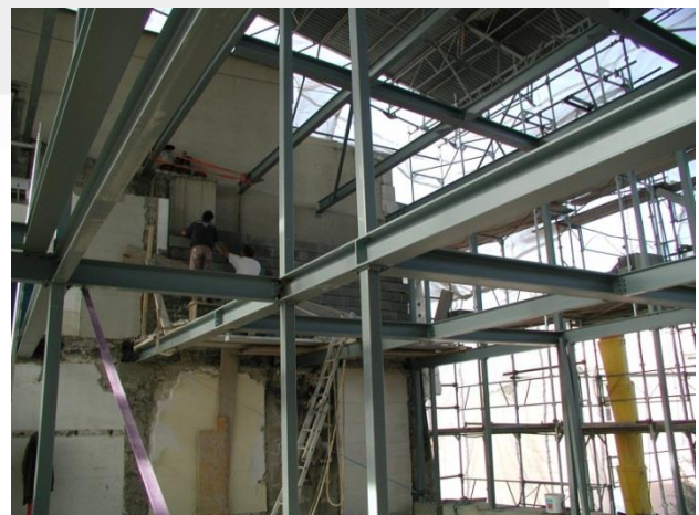
Illustration : charpente métallique
