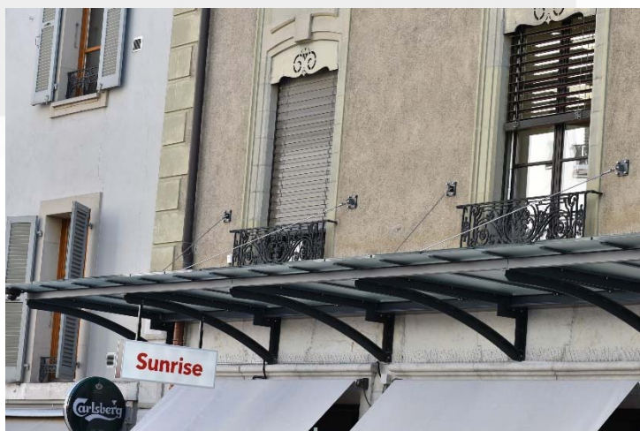
Illustration - Après pose de la nouvelle marquise - Situation avec recul
