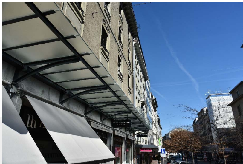
Illustration - Après pose de la nouvelle marquise - Perspective sous l'ouvrage
