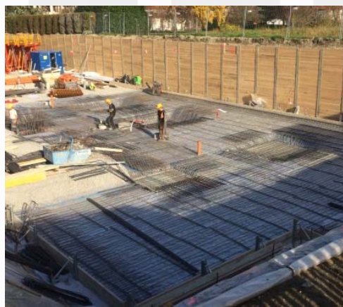
Illustration : ferrailage du radier
